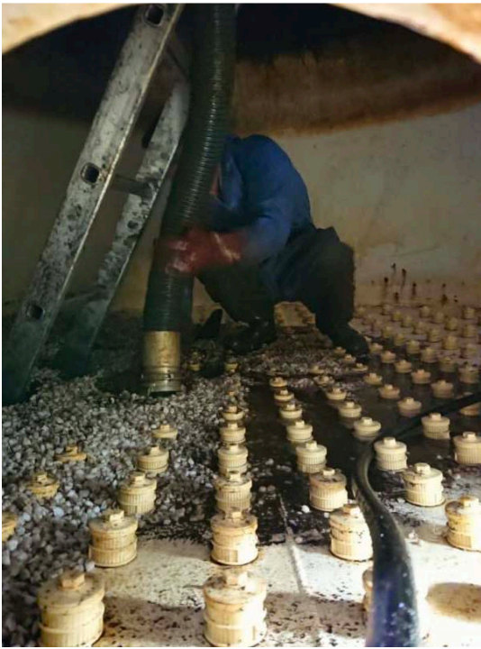
Changement du média filtrant dans une cuve spécifique
